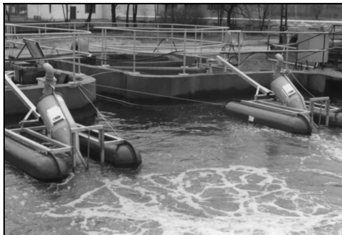
Abb. 3: Montage der Wendelbelüfter (links) und Wendelbelüfter im Einsatz (rechts) auf der Grubenwasserreinigungsanlage Schwarze Pumpe.
