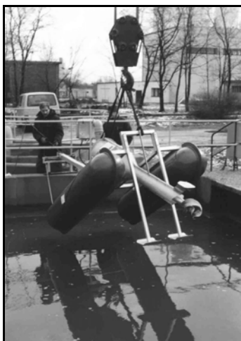
Abb. 3: Montage der Wendelbelüfter (links) und Wendelbelüfter im Einsatz (rechts) auf der Grubenwasserreinigungsanlage Schwarze Pumpe.
