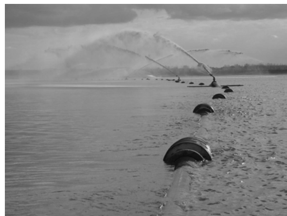
Abb. 4: Suspensionsverteilung im Koschener See mit Kreisregnern (Foto: BTU Cottbus).
