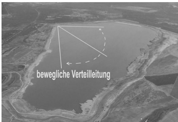
Abb. 6: Einspülung EHS in den TBS Spreetal NO.
