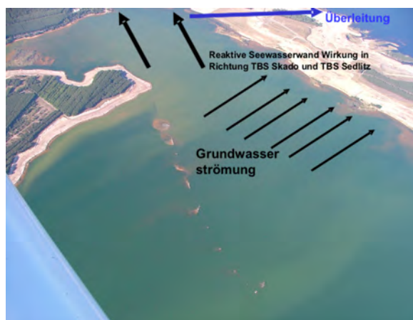
Abb. 9: Reaktive Seewasserwand TBS Koschen.
