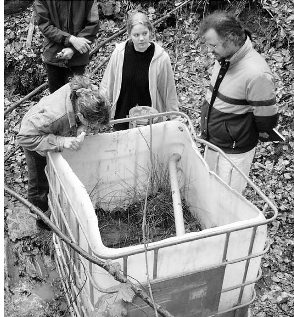
**Abb. 2:** Teil einer RAPS-Pilotanlage zur passiven Grubenwasserreinigung im Hagental bei Gernrode/Harz. Angehende Studenten werden in die Grubenwasserproblematik eingewiesen und haben aktiv am Bau mitgewirkt.
