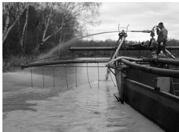
Abb. 2: Eintrag der Dolomitsuspension mit Sprühkanonen.
