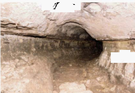
Abb. 7: Gang I der Trojanischen Quellhöhle. Höhe ca. 1,30 m.
